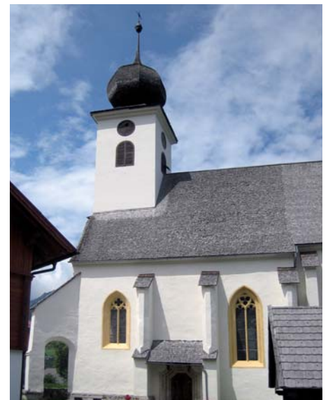
Das nächste Projekt: Im heurigen Jahr sollen die Renovierungsarbeiten an der Margarethenkirche in Oberhaus fortgesetzt werden.
